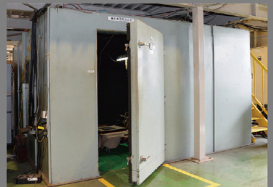
騒音測定用防音室
